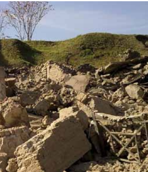
Pompeji, Schola armaturarum an der Via dell'Abbondanza, die am 5.11.2010 zusammengestürzt ist
